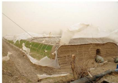
甘肃省民勤县大坝乡张五村遭受严重破坏的拱形温室
